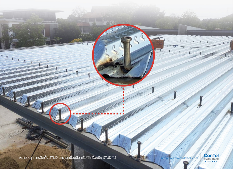
การเชื่อมมือ ด้วยเครื่องเชื่อมไฟฟ้า
